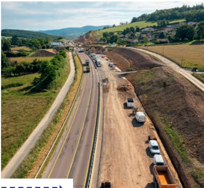
Les travaux de terrassement ont permis de modeler la partie sud de la RN 79 en vue de la construction des futures chaussées et ouvrages.
