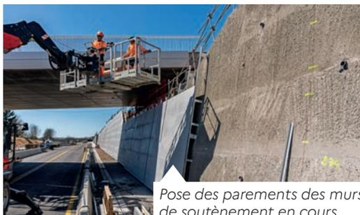
Pose des parements des murs de soutènement en cours.
